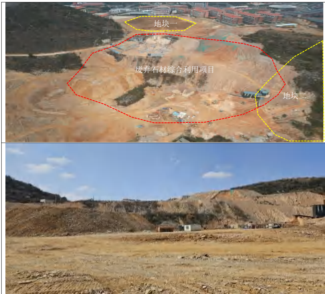
图 4-6 废弃石材综合利用项目现场踏勘
